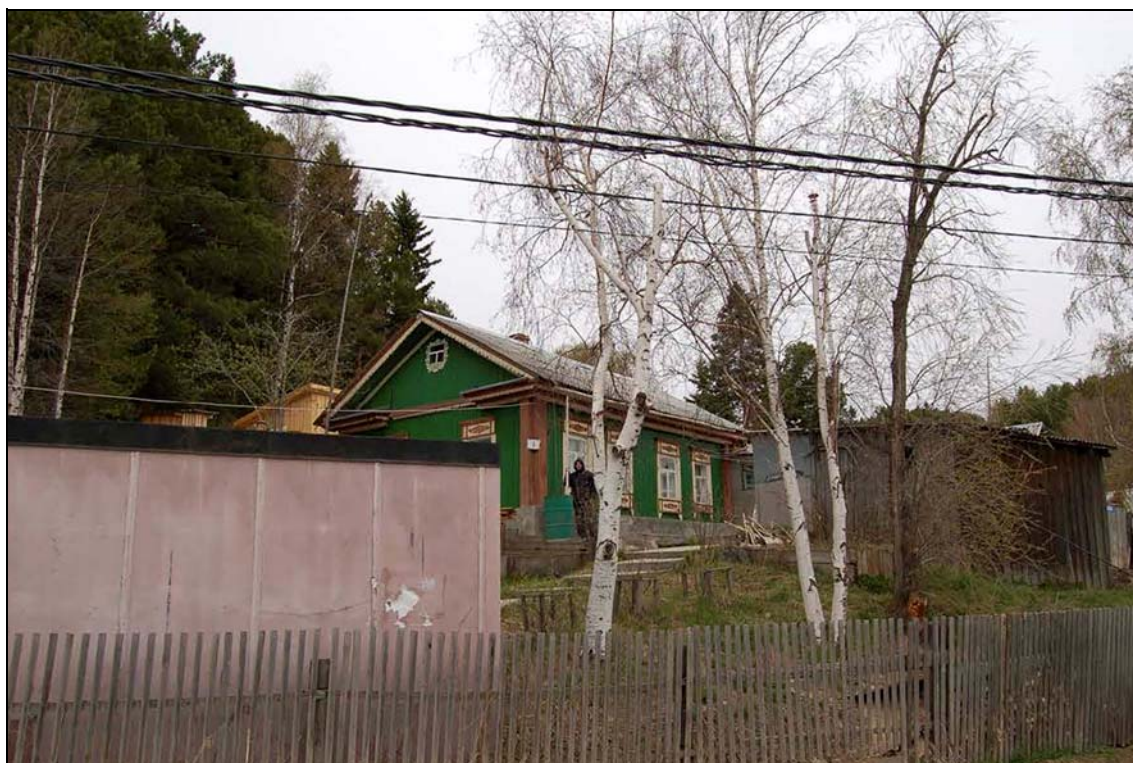
Ил. 21. ХМАО – Югра, г. Ханты-Мансийск, р-н Самарова. Жилой дом по ул. Набережная, д. 1. Фото: М.Н. Пальянова (2007 г.)
